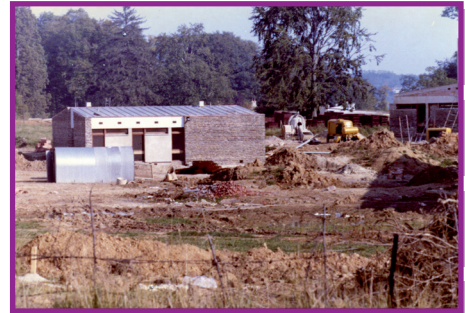
Édification des bâtiments - 1968/1969
